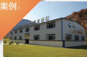
含氰污水应急处理站
