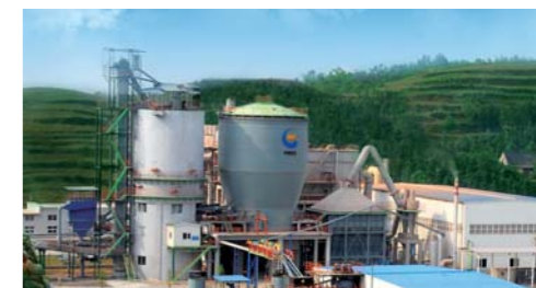
建设中的原矿焙烧项目
