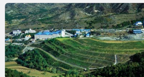
治理后的尾矿库
