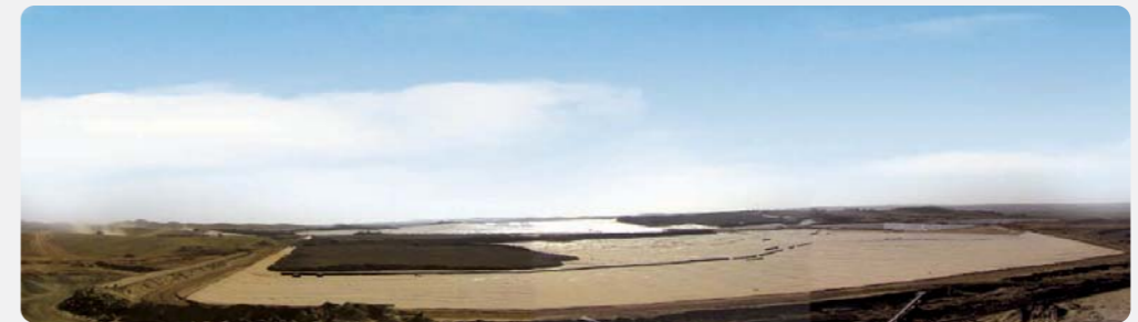
贵液池采用HDPE地膜双层铺衬
