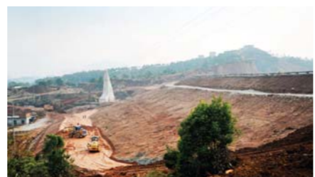
尾矿干堆项目：既节约用地，又便于复垦，实现了安全环保排放
