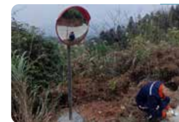
湖南鑫瑞公司为驻地合仁坪村路段安装交通凸面镜
