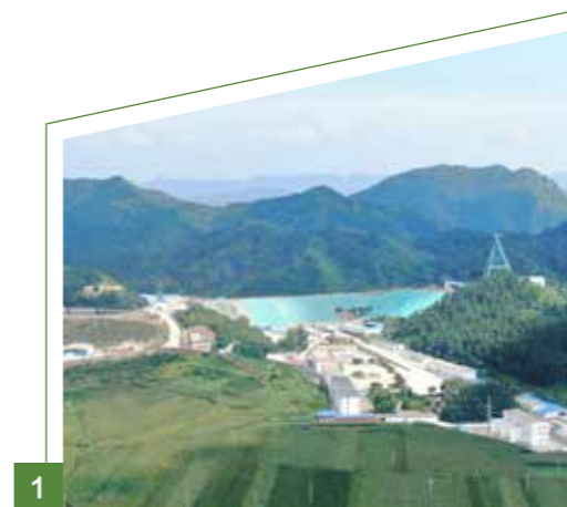
1 凌源日兴公司尾矿库坝基绿化工程
