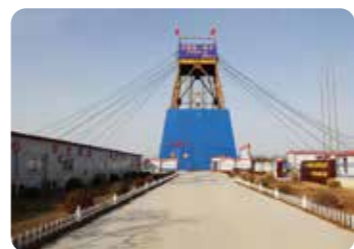
中国黄金建设纱岭金矿项目
