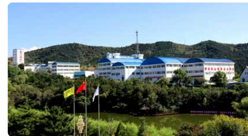
辽宁排山楼公司厂区
