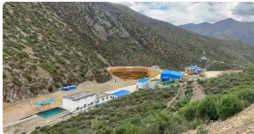
西藏华泰龙建设斯布沟水处理厂
