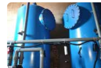
辽宁二道沟公司为楼上村安装供水设备
