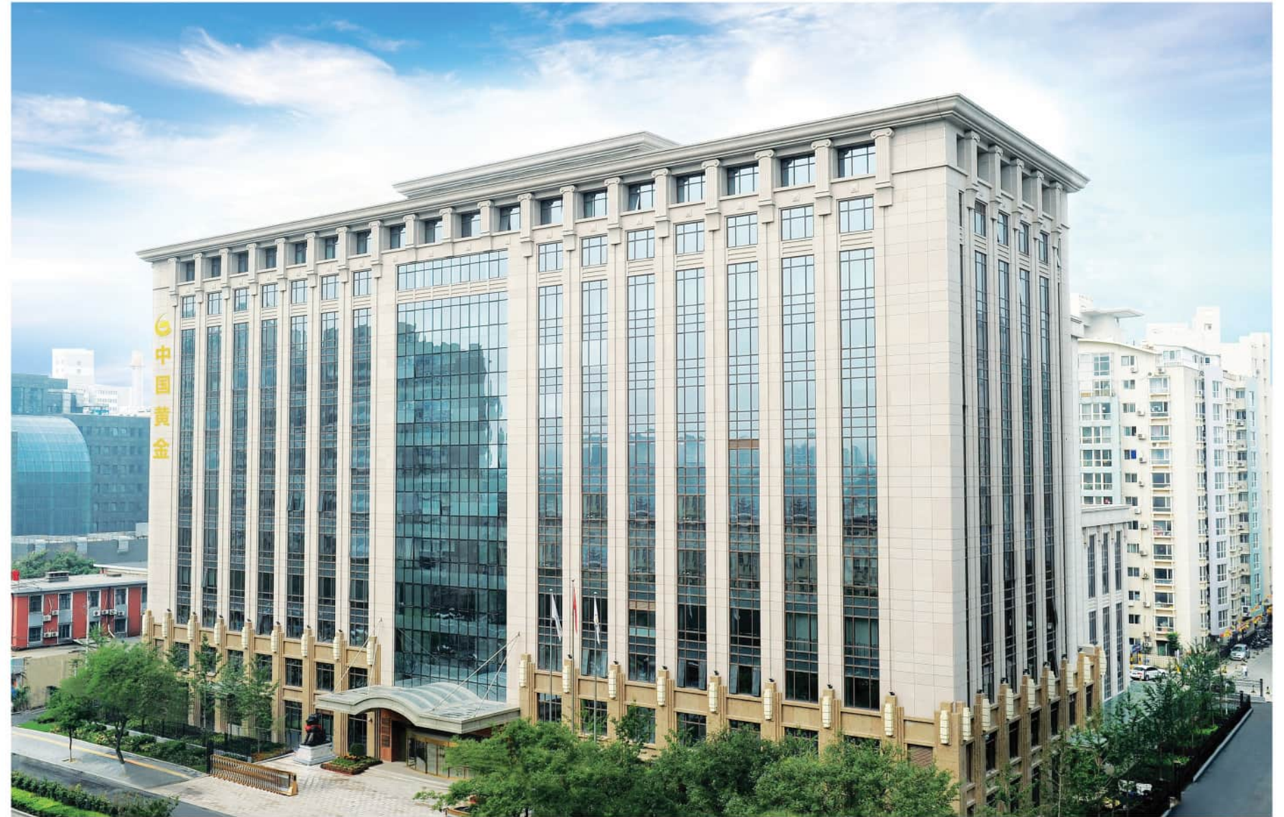
中国黄金总部大楼
