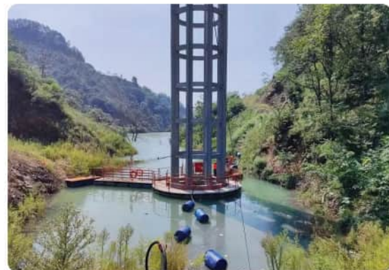
河南金源公司尾矿库溢流井远程控制系统
