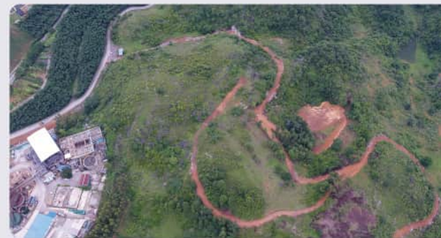
贵州锦丰公司为社区修建产业路
