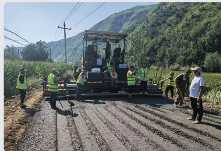
河南秦岭公司铺设道路
