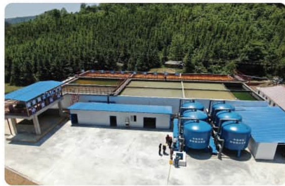
黔西南金龙公司污水处理厂
