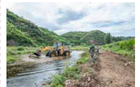
河北东梁公司为驻地疏通河道，修复道路
