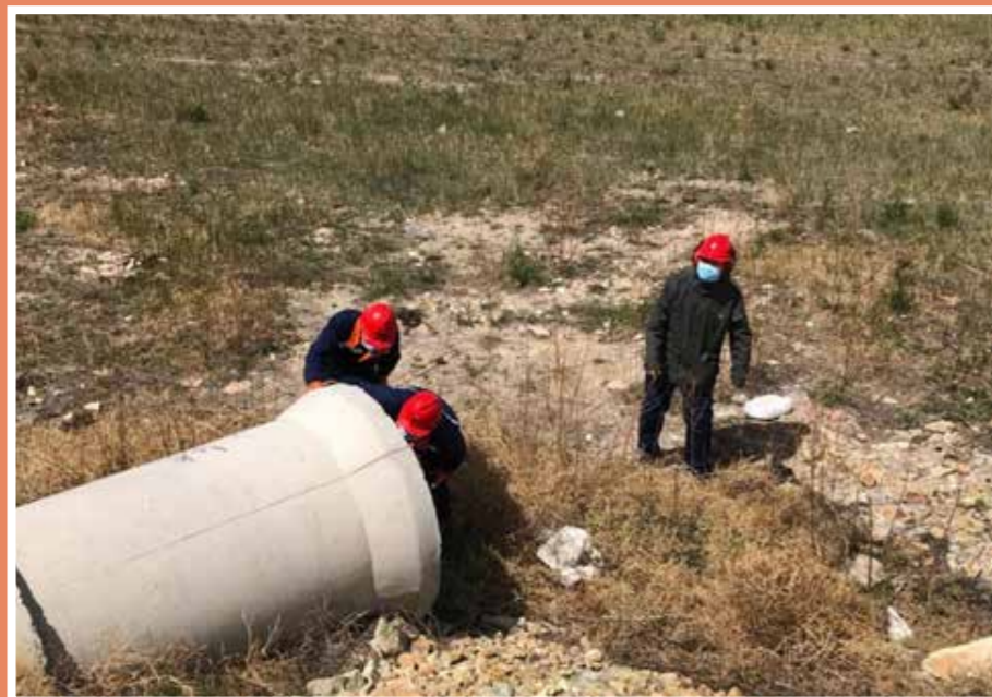
对防汛设施进行检查
