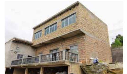
贵州锦丰公司为社区农户庭院安装防护栏
