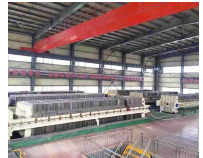
辽宁排山楼公司尾矿压滤工程
